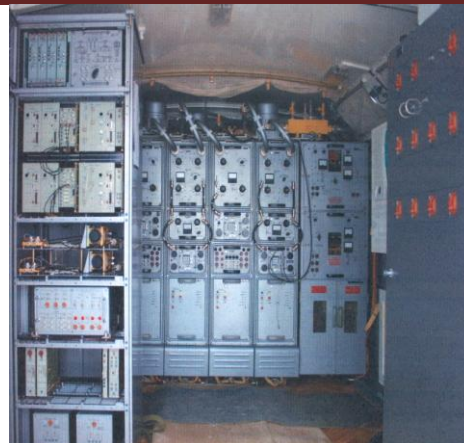
Рисунок 6 - Внутренний вид аппаратной радиомаяка РСБН-4НМ
